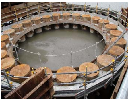
鋼管矢板施工全景
