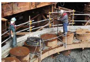
中詰めモルタル打設
