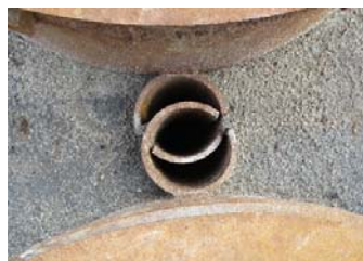
鋼管矢板継手
