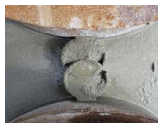
中詰めモルタル完了
